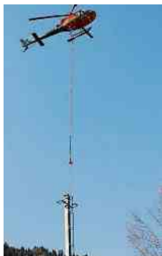
Der Skilift im Rietbad wurde mit einem Helikopter demontiert.
