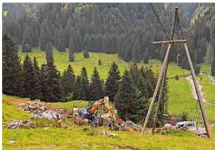
Die Fundamente für die zehn Masten werden ab der Thurwis über den Schafboden bis hinauf zum Rotsteinpass betoniert.
